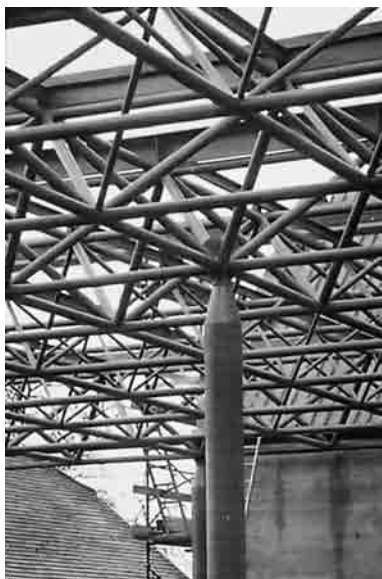
Рис. 1. Каркас крыши, сваренный проволокой Böhler Ti 52-FD
