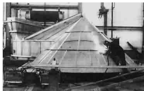
Рис. 3. Влажный фильтр (корневой слой — сварка с использованием электрода с покрытием FOX CN22/9N и сварочной проволоки CN 22/9 N-IG (TIG, GTAW — дуговая сварка вольфрамовым электродом в газовой среде соответственно), заполняющий и облицовочный слой — сварка CN 22/9 N-FD
