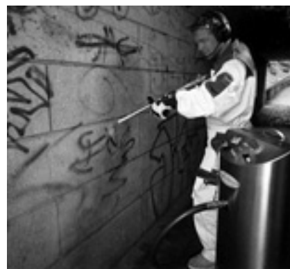
Рис. 9. Очистка поверхности сухим льдом
