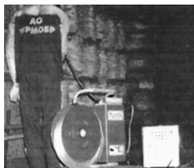
Рис. 2. Сварка алюминиевых электроконтактных переходов полуавтоматом ПШ 107 ВА
