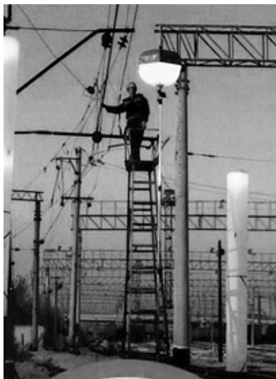
Рис. 6. Мобильные осветительные установки "Световая башня" и "Световой шар"
