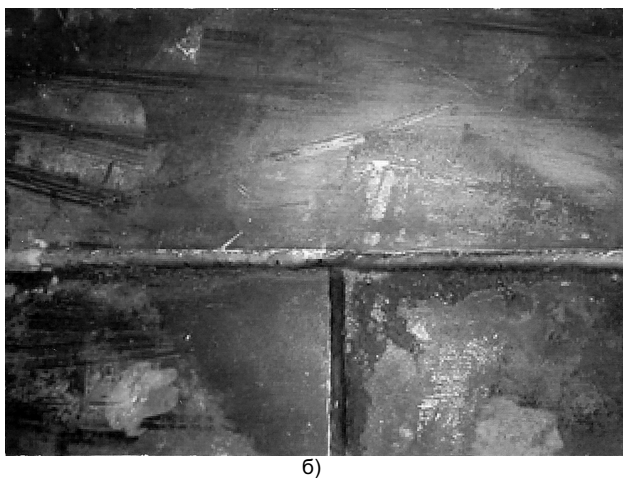
Рис. 2. Схема сварки (а) и зоны тройного нахлеста (б) центральной части днища резервуара
